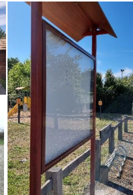
Installation d'un panneau d'affichage à l'entrée du camping
