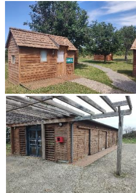
Nettoyage et passage d'un saturateur sur les cabanes et la salle de loisirs
