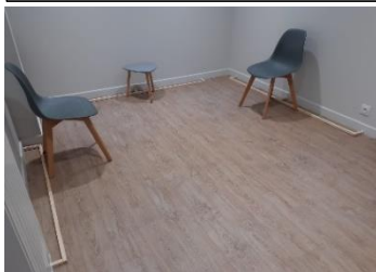
Installation de barres de protection des murs dans les salles d'attente
