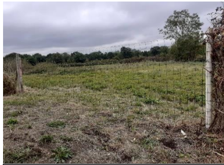
BASSIN D'ORAGE DE RIERE : Création d'un grillage permettant la fermeture du site et facilitant l'accès pour l'entretien.
