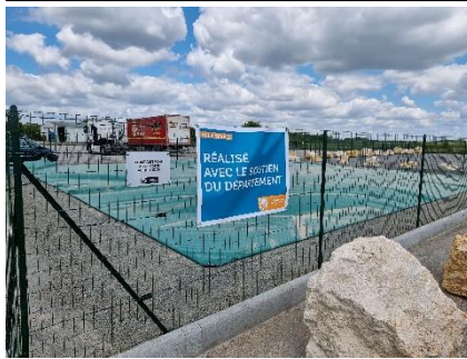
AURALIS Installation d'une nouvelle bâche incendie sur le parking d'Auralis. Réalisé par l'entreprise Thiollet
